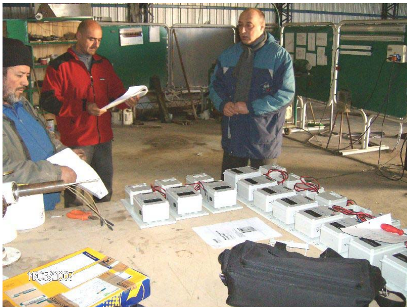
Figura 5.7 - Revisión general medidores de energía EM/12 - 11-05-2007
