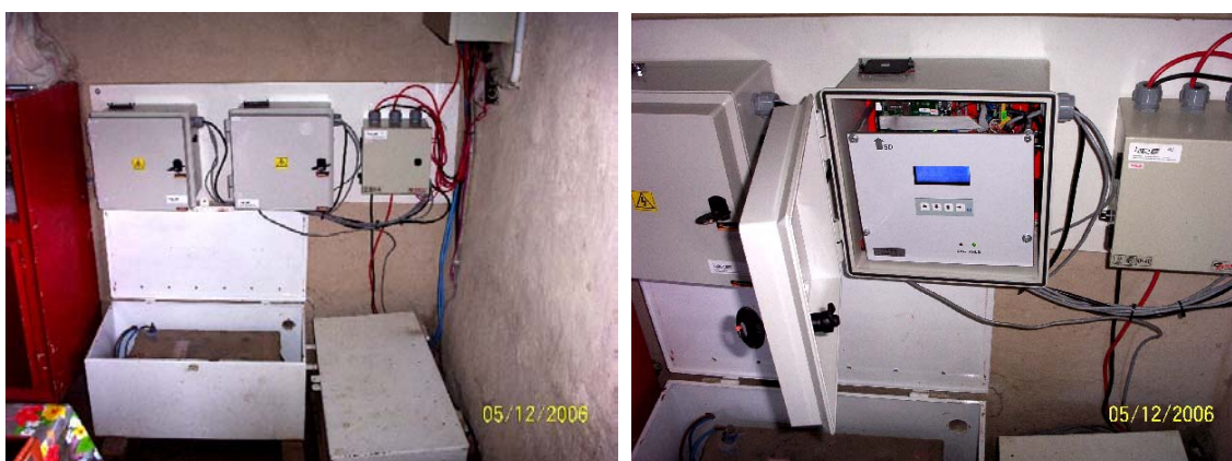
Figura 3.6 – Vista interior instalación sistema 8 Hermanos día 5-12-06 (Pocitos de Quichaura)
