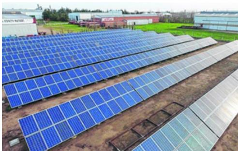
Fig. 1. Planta fotovoltaica de piso, 200 kW. Parque industrial de Armstrong
