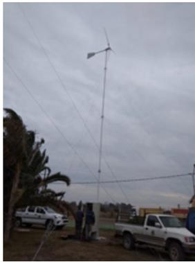
Fig. 4. Aerogenerador Wintec 1500 W en torre de 15 m
